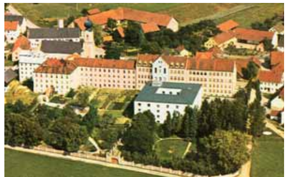
Kloster und Schulgebäude Oberroning
